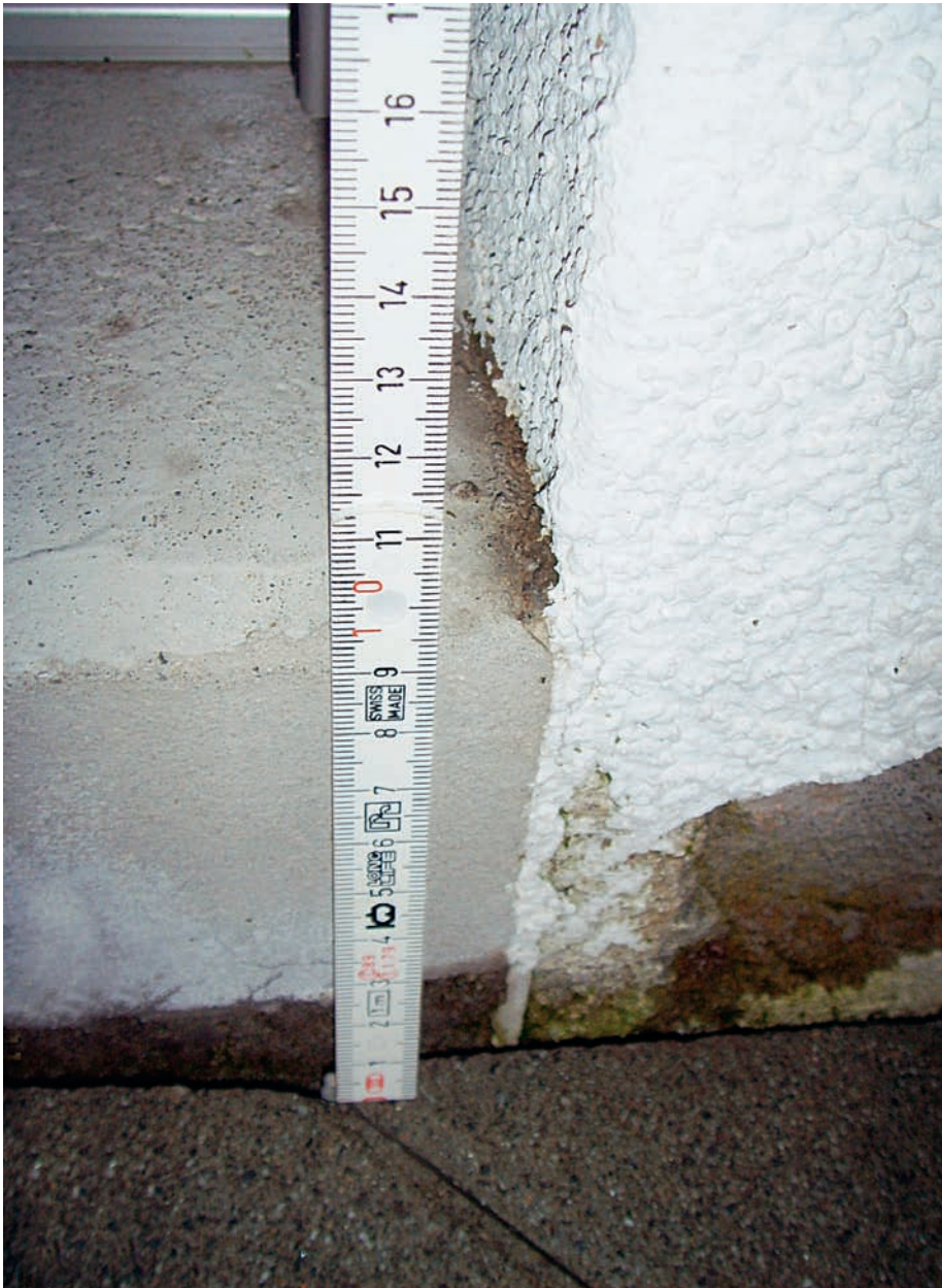
3 Kein Rost im feuchtebelasteten Sockelbereich – der Grund für die Rostausblühungen kann nicht in Feuchtigkeit alleine liegen.
