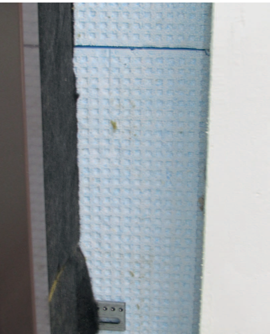
Bild 7: Verputzen der Hohlsturzuntersichten in den Rollladenkästen.
