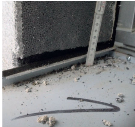
Bild 8: Putzbordenanschlüsse.
