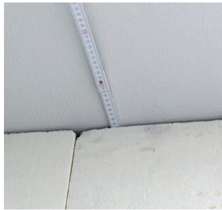
Bild 4: Wand-Decken-Anschluss auf einem Balkon.
