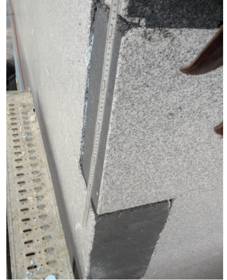
Bild 9: Eckausbildung mit den Dämmplatten.
