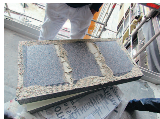
Bild 2: Kontrolle der Dämmplattenverklebung.
