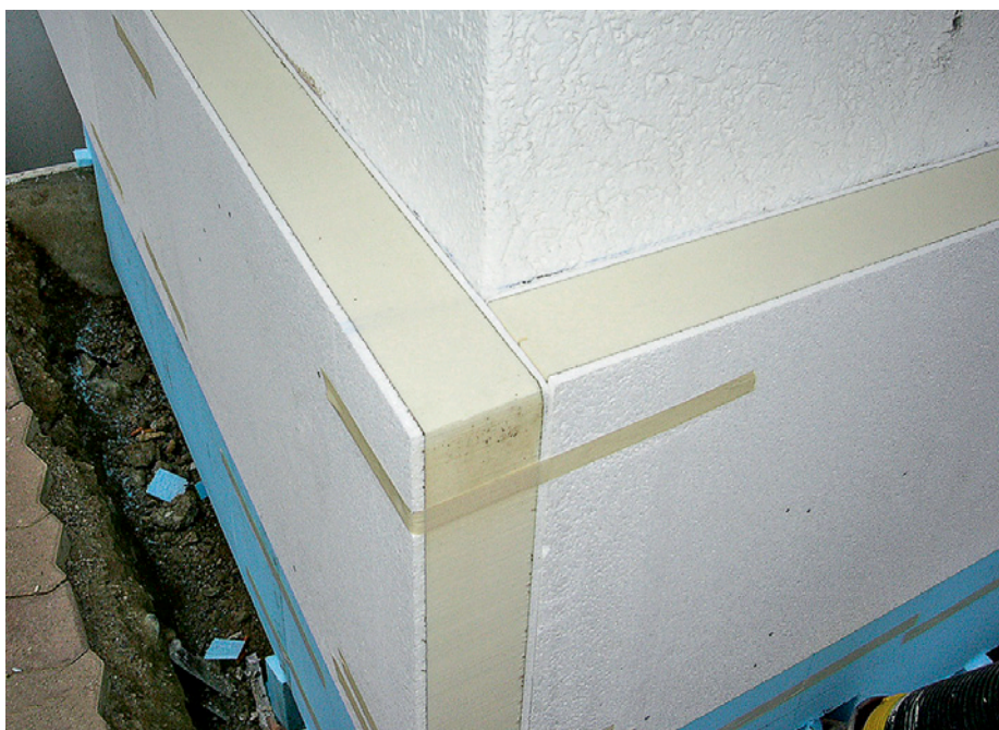
Nach positiv verlaufenen Haftzugtests werden die HiCompact-Dämmplatten von Marmoran direkt vollflächig auf die alte Deckbeschichtung aufgeklebt. (Bild: Saint-Gobain Weber)
