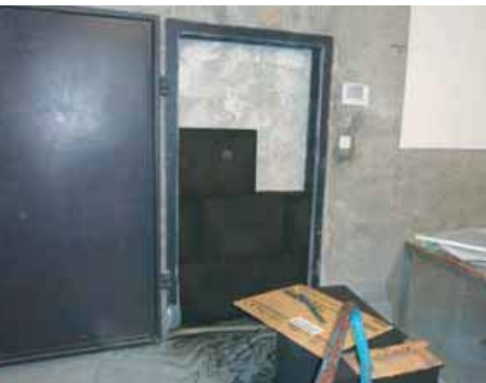
Bekleidung des Prüflings mit Schaumglasdämmplatten auf den vorhandenen Innengrundputz.
