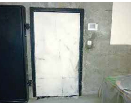
Zementfreier System-Innengrundputz auf die Schaumglasdämmung.
