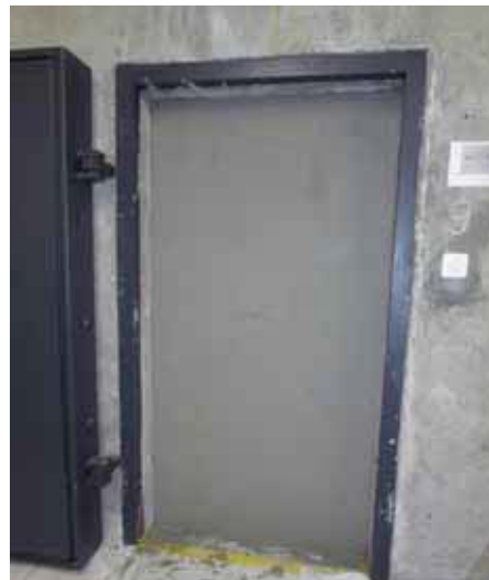
Einbau (links) und Fertigstellung des Prüflings.
