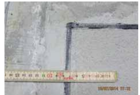
Detail geschnittene Anschlussfuge.
