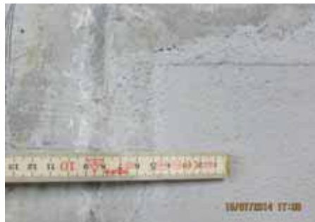
Detail ungeschnittene Anschlussfuge.
