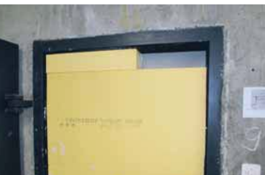
Prüfling mit fast fertig verlegten XPS-Dämmplatten vor dem Grundputzauftrag.
