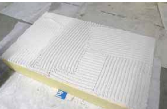
Vollflächiger Klebemörtel- auftrag im Zahnpachtel- Verfahren rückseitig auf die XPS-Dämmplatten.
